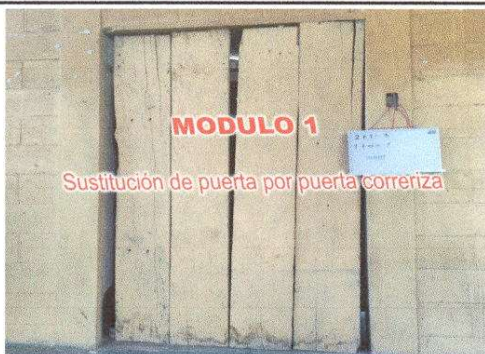
Foto 3: Sustitución de puerta correriza de 2.24 x 1.30 metros. Modulo 1.
