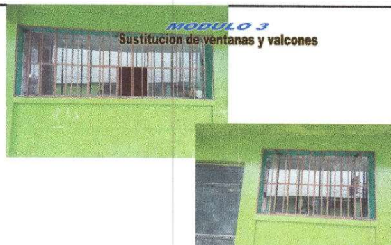
Foto 6: Sustitucion de ventanas y valcones, un total de 4.03 x 1.00 metros. Modulo 3.
