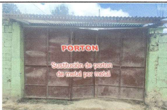
Foto 5: Sustitución de portón de metal por metal de 3.18 x 2.30 metros.
